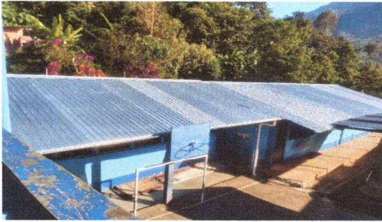
Foto 1: ENTECHADO DE LAS AULAS Y LA DIRECCION FINALIZADO.
