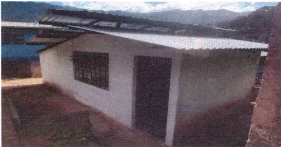
Foto 3: ENTECHADO DE LA COCINA EJECUTADO CON LAMINAS TRAQUELADAS CALIBRE 26 Y REPELLADO EN EL INTERIOR Y UNA PARTE EXTERIOR DE LA MISMA.
