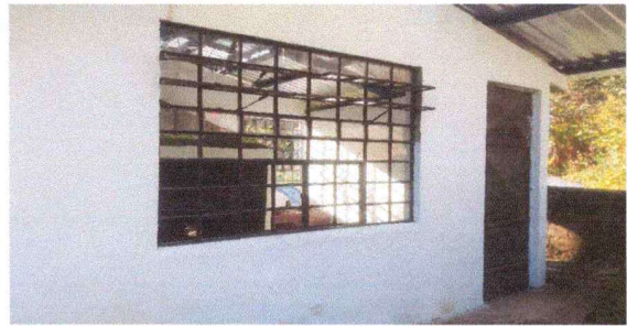
Foto 6: SE RESTITUYERON LOS VIDRIOS DE LAS VENTANAS QUE CONFORMAN LA COCINA.
