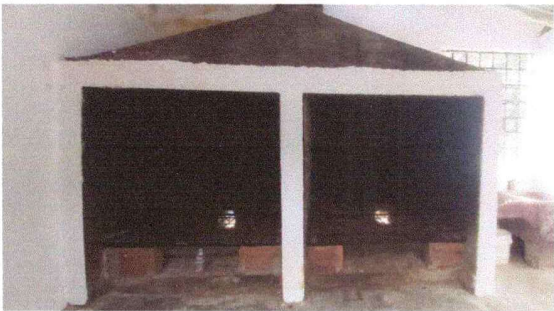
Foto 5: SE REMODELO ESTA PARTE DE LA COCINA CON NUEVAS BASES, DOS PARRILLAS DE HIERROS Y MEJORAMIENTO DE LA MESA DE TRABAJO DE COCINA (MESA DE CEMENTO Y AZULEJO)
