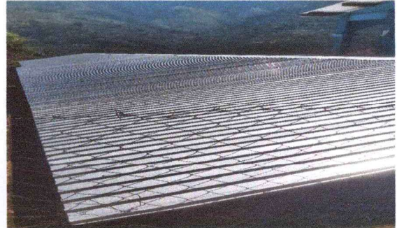
Foto 2: SE HIZO TOTALMENTE EL CAMBIO DEL ENTECHADO DE LAS AULAS Y DIRECCION EN SU PARTE POSTERIOR.
