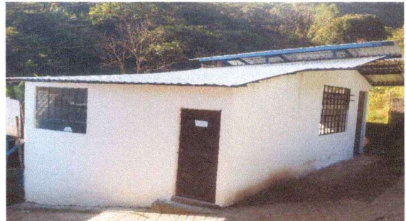
Foto 4: VISTA DEL LADO ESTE DE LA COCINA QUE SE INTERVINO CON EL CAMBIO DE ENTECHADO Y REPELLADO.
